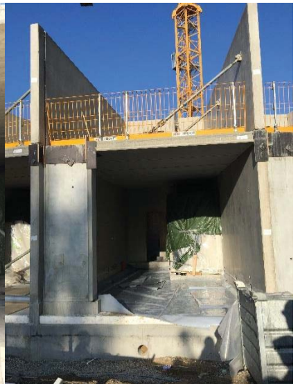
Aufbau – Sauberkeitsschicht, Streifenfundament, Sand auffüllen, 20 cm Isolierung, Radonsperre, 20 cm Isolierung, Estrich
