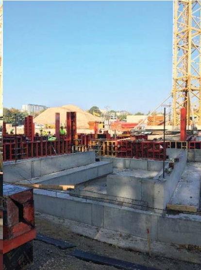
Fertigstellung des Sockels
