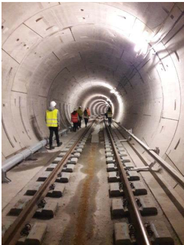
Im Tunnel der Metro
