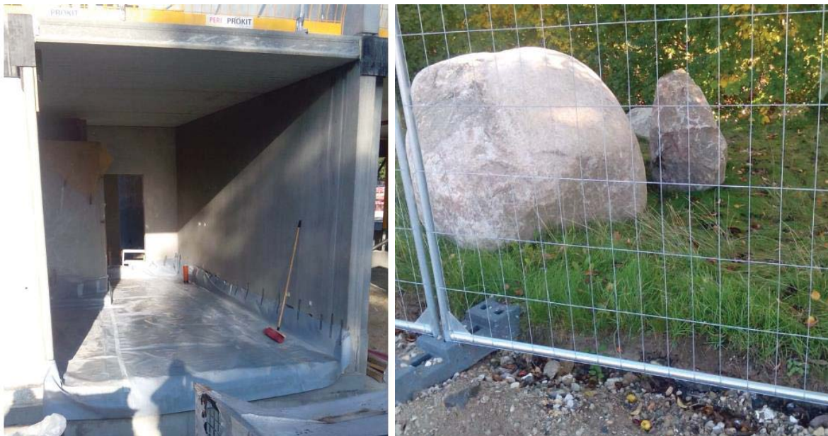
Abbildung 2&3: Blick in eine Wohnung im Rohbauzustand mit Radonsperre und Findlinge an Baustellenrand
