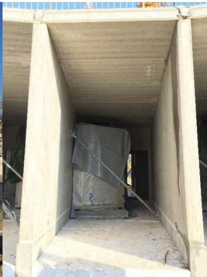
Decke fertig – der Kasten ist das Badezimmer; Sichtbeton bleibt bestehen, keine Farbe an den Wänden; keine Nägel dürfen verwendet werden
