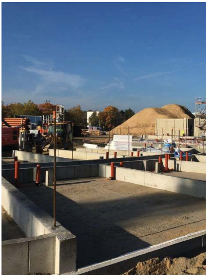
Auffüllen mit Sand – rot = Anschlüsse an Leitungen
