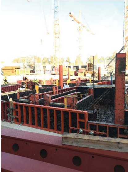
Aufbau der Schalung
