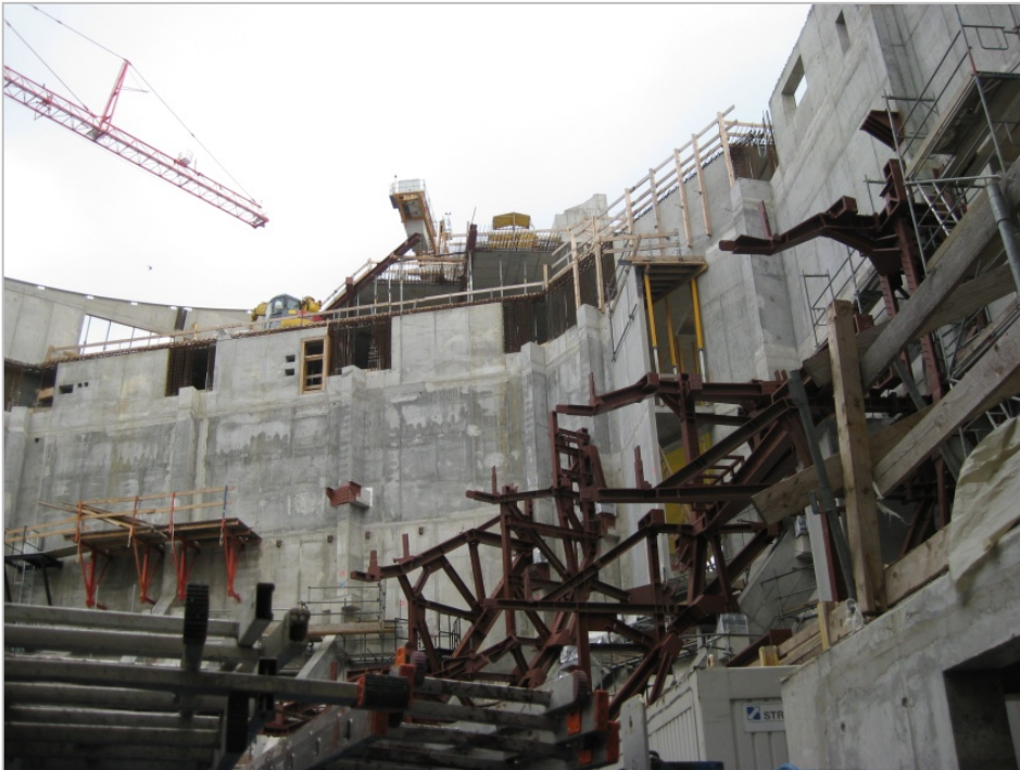
Abb. 7: Innenansicht Elbphilharmonie Hamburg 1
